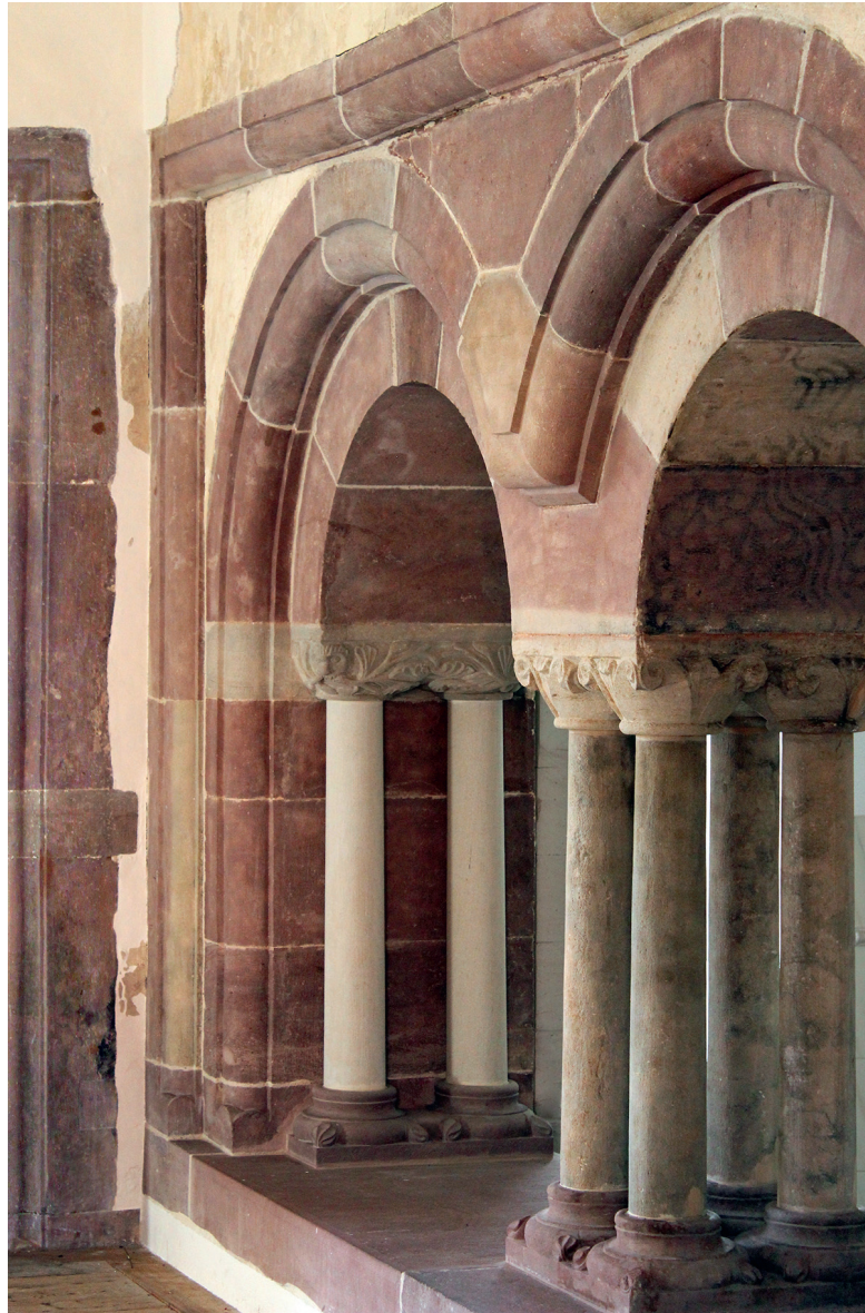
Abb. 8: Doppelarkade der Nordwand mit Vierersäulengruppe, Doppelkapitell mit Rankenschlingen und Marmorierungen. Links die Rechteckblende des nördlichen Doppelbogens der Talseite (Foto: Goswin v. Mallinckrodt)
