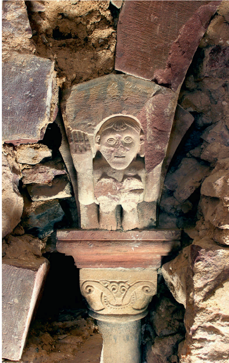
Abb. 6: Mittlere Doppelsäule der Hofarkade mit Werkmeisteratlant und Marmorierungen (Foto: Goswin v. Mallinckrodt)
