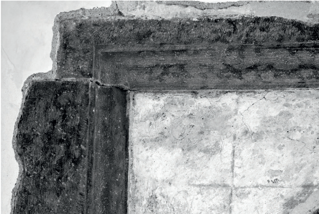
Abb. 9: Infrarot-Aufnahme der Rechteckblende des südlichen Doppelbogens der Talseite mit Marmorierungen (Foto: Gerd Brander)
